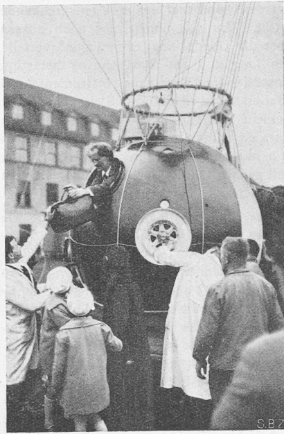
Abb. 2. Kabine mit seitlicher Rillenscheibe für die Ventilleine (Startversuch vom 14. Sept. 1930.).
