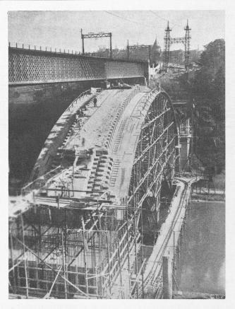
Abb. 26. Mittlerer Gewölbestreifen hinterbetoniert.
