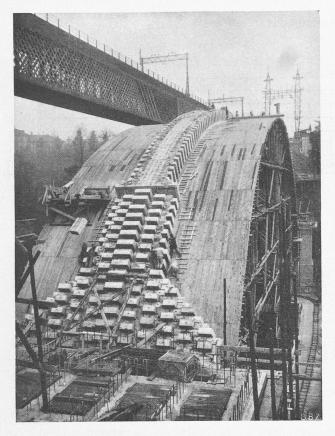
Abb. 25. Stand der Gewölbemauerung am 7. Dezember 1928.
