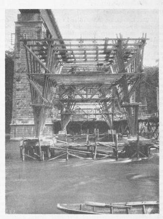
Abb. 19. Lehrgerüst, Bauzustand am 8. September 1928.
