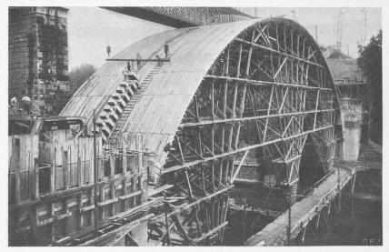
Abb. 23. Beginn der Gewölbemauerung, erstes Element.
