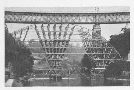
Abb. 22. Bauzustand des Lehrgerüstes am 26. September 1928 (dicht dahinter die Eisenbahnbrücke).
