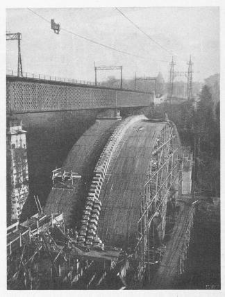
Abb. 24. Erstes Gewölbe-Element fertig, Beginn des zweiten.
