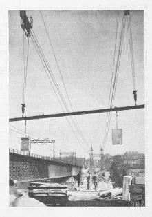
Abb. 27. Transport der Gewölbe-Quader.
