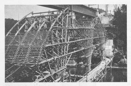
Abb. 21. Lehrgerüst, Bauzustand am 24. September 1928.
