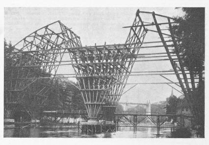
Abb. 20. Lehrgerüst, Bauzustand am 24. September 1928.
