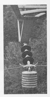
Abb. 8. Isolatorenkette für Winkelmast.
