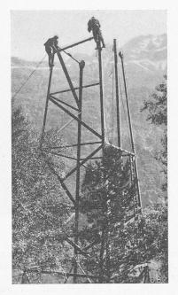
Abb. 11. Aufbau eines Gittermastes.
