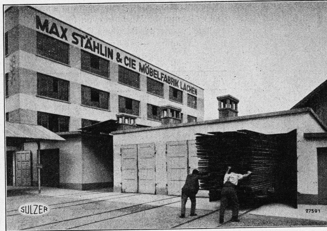
Sulzer Holz-Trocken-Anlage mit drei Kammern
