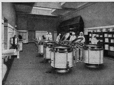
Senking-Ideal-Kochkessel und Kippköpfe aus nichtrostendem Stahl V2a. Innenkessel mit dem oberen Profilring nahtlos aus einem Stück hergestellt. Vollkommen hygienisch
