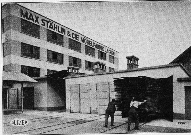
Sulzer Holz-Trocken-Anlage mit drei Kammern
