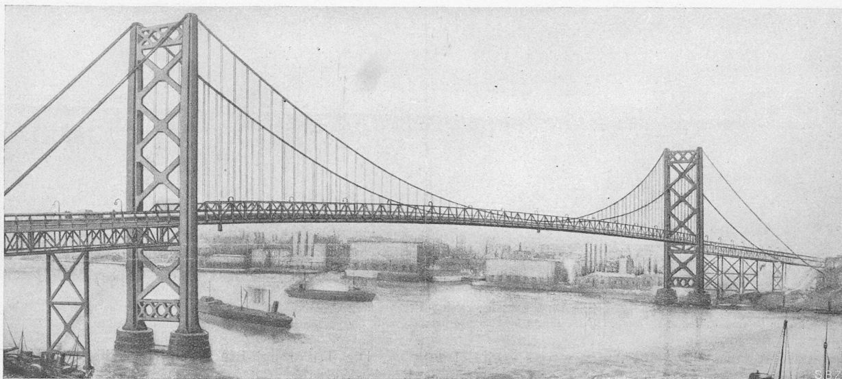
Abb. 46. Hängebrücke von 2260 m Länge und 563 m Hauptspannweite über den Detroit River (Gewicht 22000 t).
