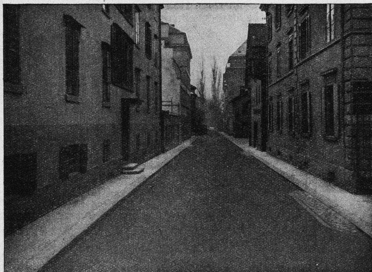
GLARNISCHSTRASSE ZÜRICH Walz-Asphalt: Topeka, 6 cm stark
