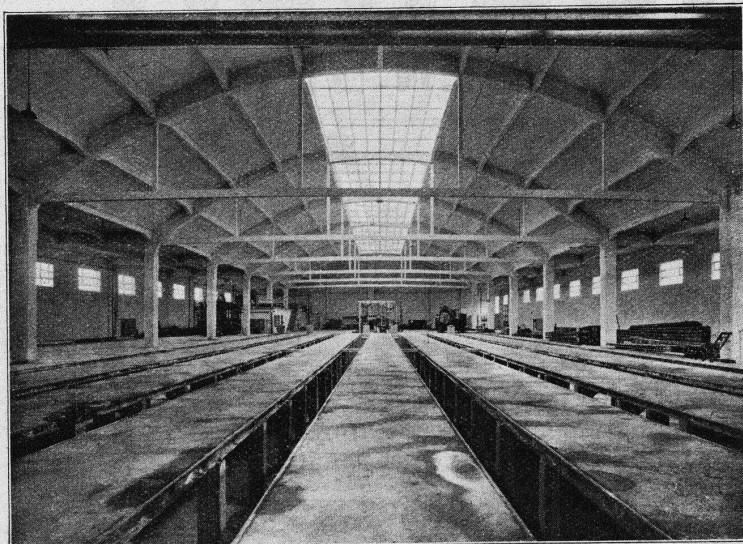
Tramdepot Morgartenstrasse, Basel
