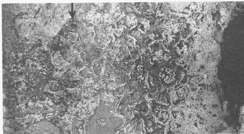
Abb. 7. Infiltrationsbahnen (Schwindrisse in Weisskalkverputz) bleiben nach weitgehender Abwitterung der Mauerfläche als Erhabenheiten stehen. In Richtung des Pfeiles sind die Ausscheidungsrythmen gut sichtbar. Etwa 1/14 nat. Gr.
