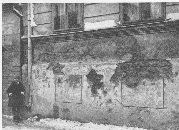
Abb. 8. Abfallen grosser Platten eines dicken, dichten Verputzes von der Hausmauer (links wo das Kind steht), sowie im obern Teil des Sockels am Gebäude rechts. Zwischen Sockeloberkante und Fenstergesims ist die Verputzschicht von geringerer Dicke, es erfolgt hier Feuchtigkeitsaustritt zur Oberfläche bei teilweisem Blasenwurf. Die Infiltration reicht über das Fenstergesims. Auch hier erfolgt wieder (im Bilde nicht sichtbar, da weiter rechts) Aufplatzen des in dicker Schicht aufgetragenen Putzes und Abwerfen ganzer Schollen.
