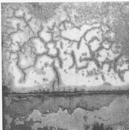
Abb. 6. Risse im Verputz als Bahnen der zur Oberfläche vordringenden Mauerfeuchtigkeit. In Umgebung der Risse erfolgt Verfarbung.
