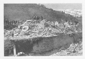
Abb. 3. Der Trümmerhaufen 5 min nach der Sprengung.
