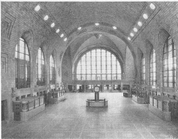
Abb. 21. Grosse Halle des Buffalo Terminal.
