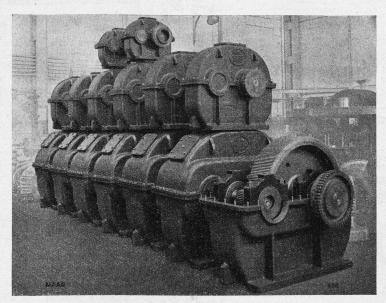
Stirn- und Schraubenräder Spezialität: gehärtet und geschliffen, grösste Genauigkeit wird auf Maag-Schleifmaschine erreicht Schneckenräder, Kegelräder Zahnstangen, Innenverzahnungen
