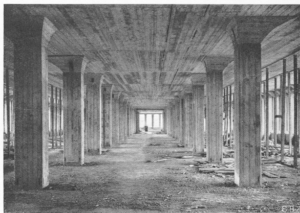
Abb. 47. Pilzdecke im 5. Obergeschoss.
