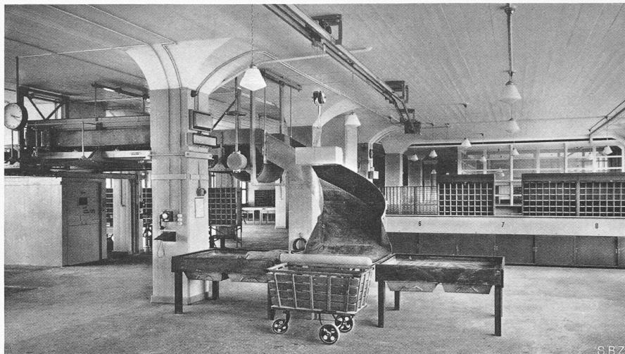
Abb. 30. Briefausgabe im 2. Stock: Ausmündung des Sack-Elevators auf den Auspacktisch.
