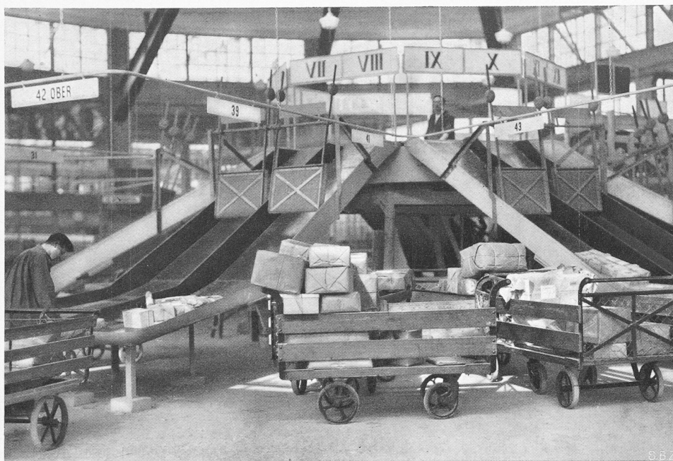
Abb. 37. Drehtisch für die Paketsortierung in der Paketausgabe für Zürich.
