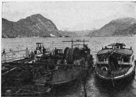
Verlegeflotte während der Verankerung des Kabels in Poiana
