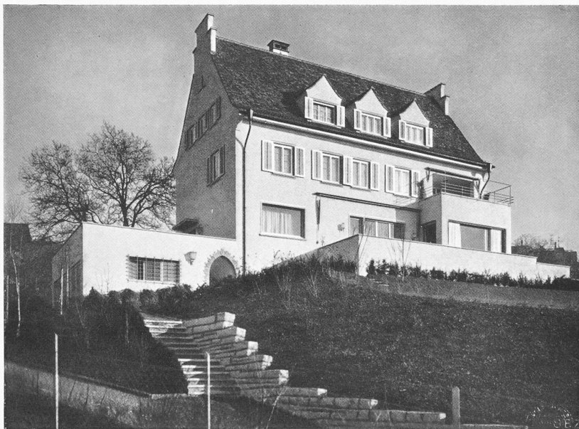
OBEN AUS SÜDEN GESEHEN UNTEN ZUGANG VON DER STRASSE HER, AUS WESTEN
