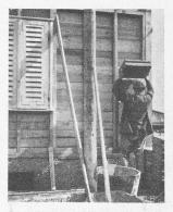
Abb. 2. Versetzen der Platten.
