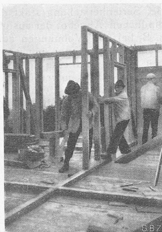
Abb. 5. Aufstellen der Wandrahmen.
