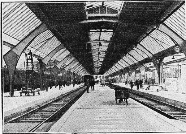
Umbau Hauptbahnhof Zürich; Perron-Längshalle I. Total 7 Hallen, nach unseren Berechnungen und Konstruktionsplänen ausgeführt.
