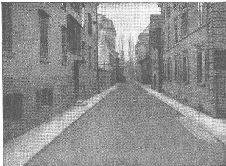
GLARNISCHSTRASSE ZÜRICH Walz-Asphalt: Topeka, 6 cm stark
