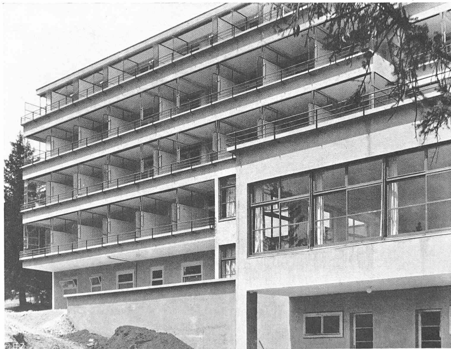
SANATORIUM BELLA LUI IN MONTANA, KT. WALLIS ARCH. A. ITTEN, THUN, UND R. STEIGER, ZÜRICH MITARBEITERIN F. STEIGER, DIPL. ARCH.
