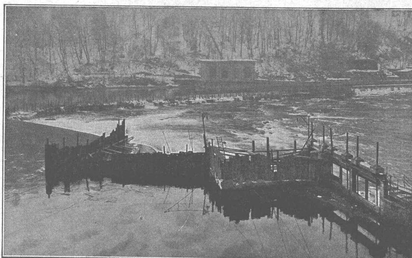
GERÜST FÜR DIE EISENBAHNBRÜCKE ÜBER DIE BIRS b. BASEL
