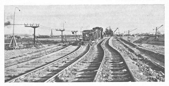
Abb. 12. Geleiserückmaschine der Lauchhammerwerke A.-G. an der Arbeit.
