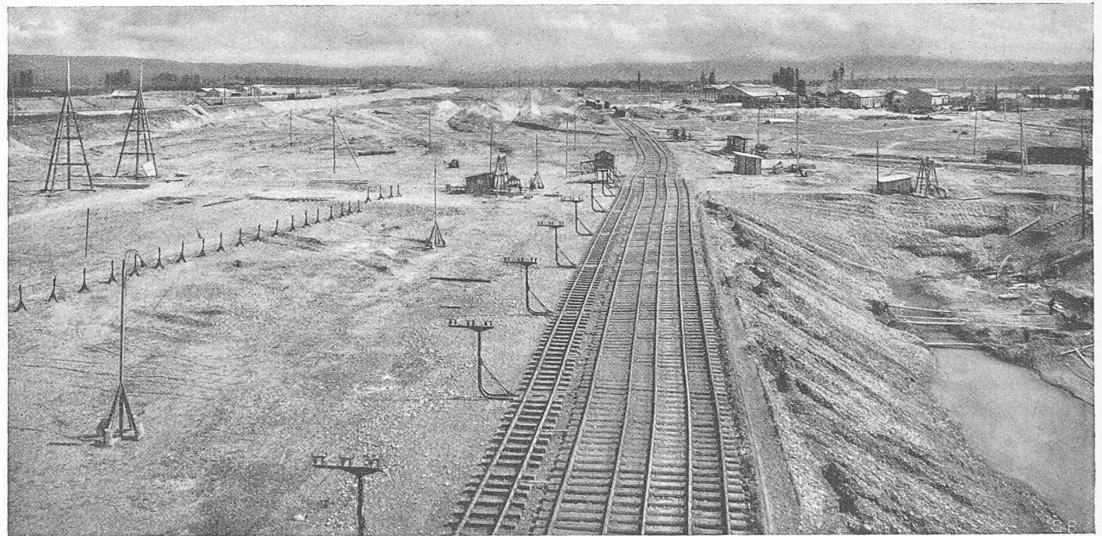
Abb. 11. Gleiseanlage für den Eimerkettenbagger und die zwei meterspurigen Bedienungseisenbahnen.
