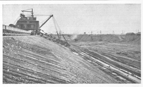
Abb. 9. Hochleistungs-Eimerkettenbagger der Lübecker Maschinenbaugesellschaft für den Aushub der Maschinenhausbaugrube.
