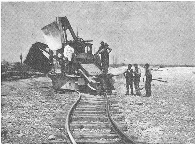
Abb. 16. Obige Maschine als Geleiserückmaschine arbeitend.
