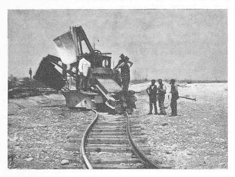
Abb. 16. Obige Maschine als Geleiserückmaschine arbeitend.
