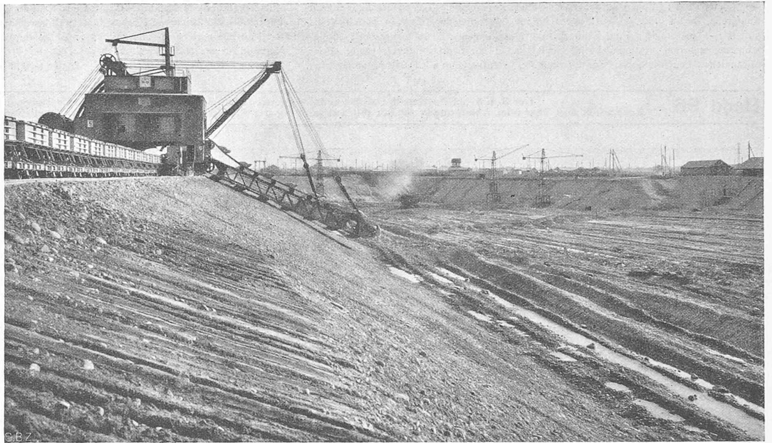
Abb. 9. Hochleistungs-Eimerkettenbagger der Lübecker Maschinenbaugesellschaft für den Aushub der Maschinenhausbaugrube.
