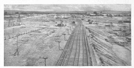
Abb. 11. Geleiseanlage für den Eimerkettenbagger und die zwei meterspurigen Bedienungsgeleise.
