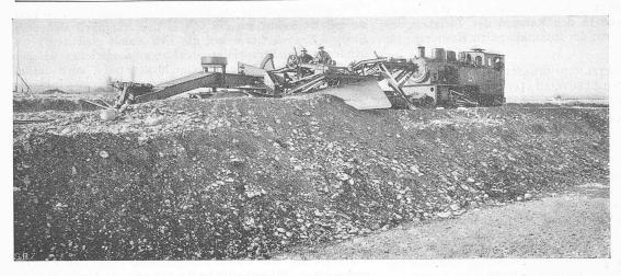
Abb. 15. Pflug- und Geleiserückmaschine der Lauchhammerwerke A.-G., als Pflug arbeitend.
