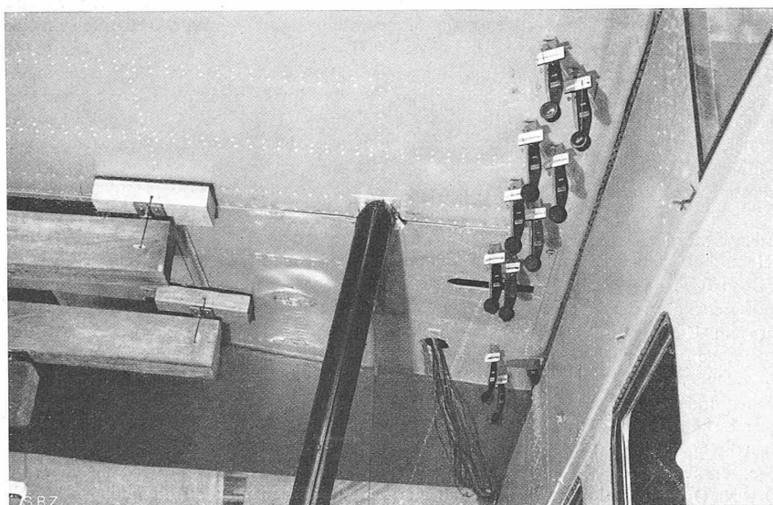
Abb. 20. Ermittlung des Verdrehungsmomentes beim Uebergang vom Flügel in den Rumpf (D V L).
