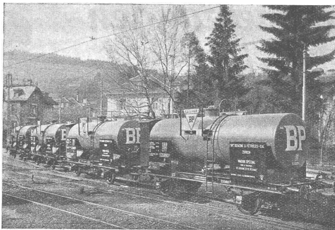
Tankwagen mit elektrisch-geschweissten Kesseln zum Transport von Benzin und Petroleum.
