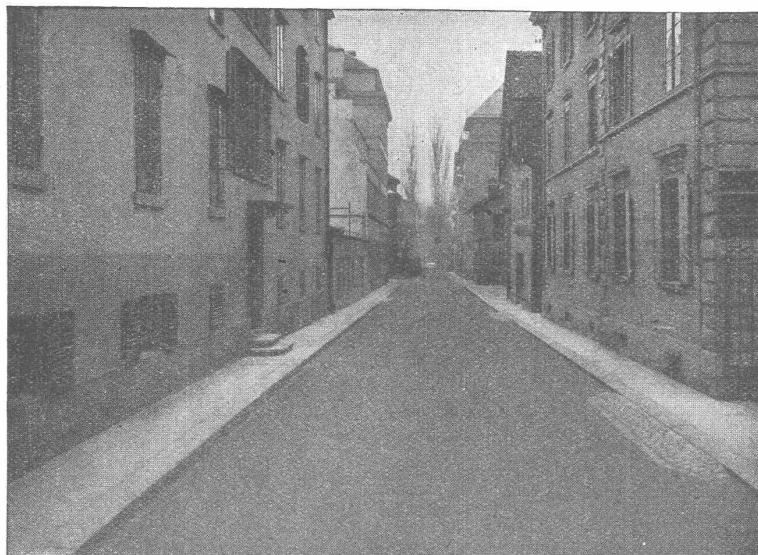
GLARNISCHSTRASSE ZÜRICH Walz-Asphalt: Topeka, 6 cm stark
