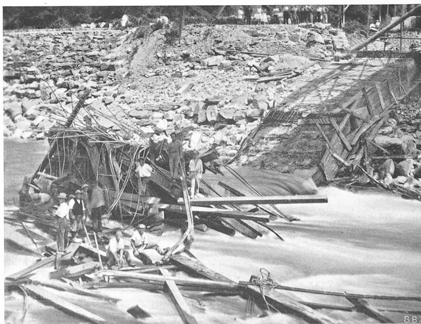
Abb. 13. Der Flusspfeiler nach dem Einsturz am 29. Juli 1930, vom rechten Ufer aus gesehen.
