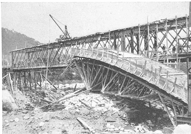
Abb. 1. Ueber dem rechtsufrigen Vorland stehen gebliebener Rest der Rüstung mit drei betonierten Gewölbemellen.
