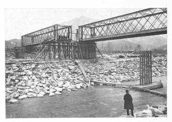
Abb. 4. Verschiebung der alten Brücke am 22./23. Febr. 1930, vom linken Ufer aus. Rechts die Stützen des Lehrgerüst-Pfeilers in der N-W-Rinne.
