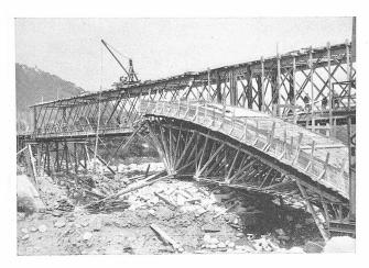
Abb. 1. Ueber dem rechtsufrigen Vorland stehen gebliebener Rest der Rüstung mit drei betonierten Gewölbelamellen.
