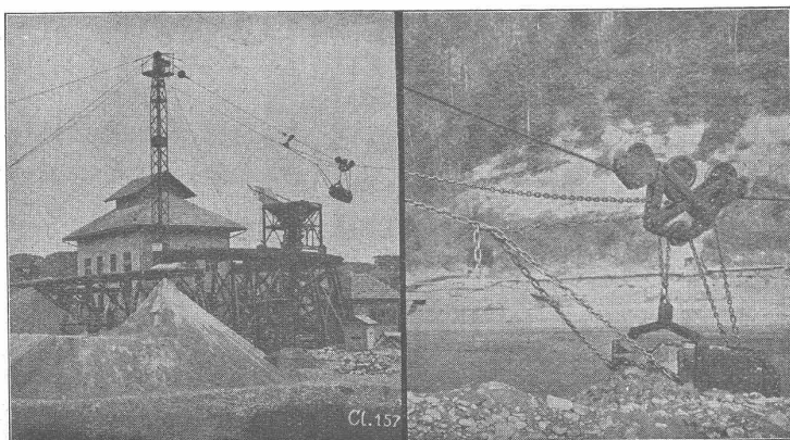
Kabelbaggeranlage in der Sense bei Laupen.
