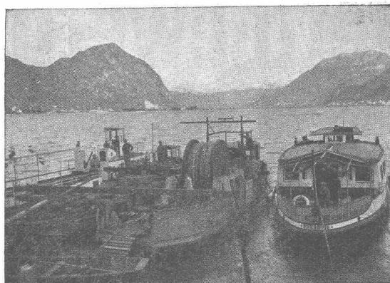
Verlegeflotte während der Verankerung des Kabels in Poiana
