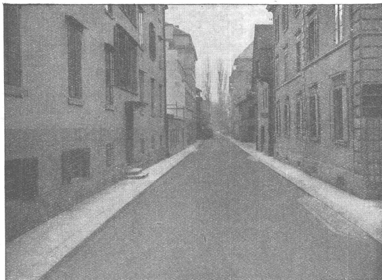
GLARNISCHSTRASSE ZÜRICH Walz-Asphalt: Topeka, 6 cm stark
