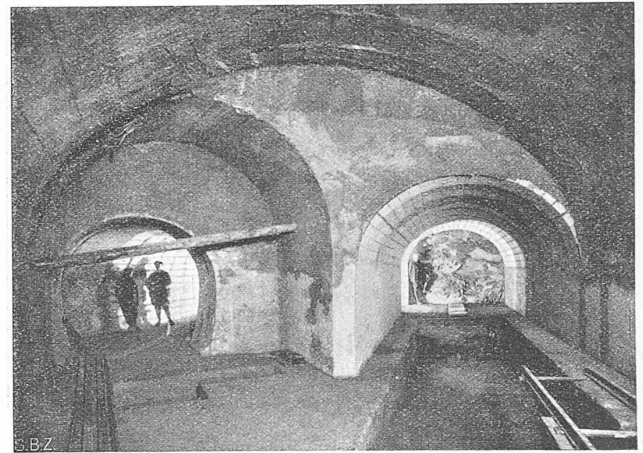
Abb. 5. Ansicht der vorläufigen Endschleufe.
