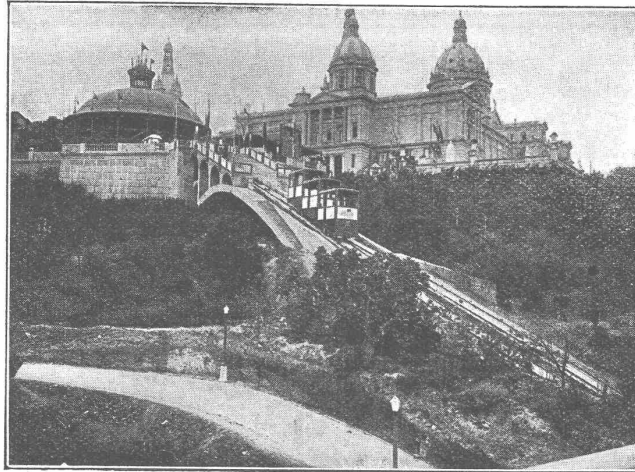
Drahtseilbahn beim Nationalpalast an der internationalen Ausstellung in Barcelona, mit Wagen bis 110 Personen fassend.
