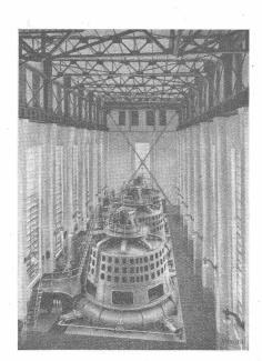
Freistrahlturbinen mit vertikaler Welle Hohe Drehzahlen Unübertroffene Wirkungsgrade
