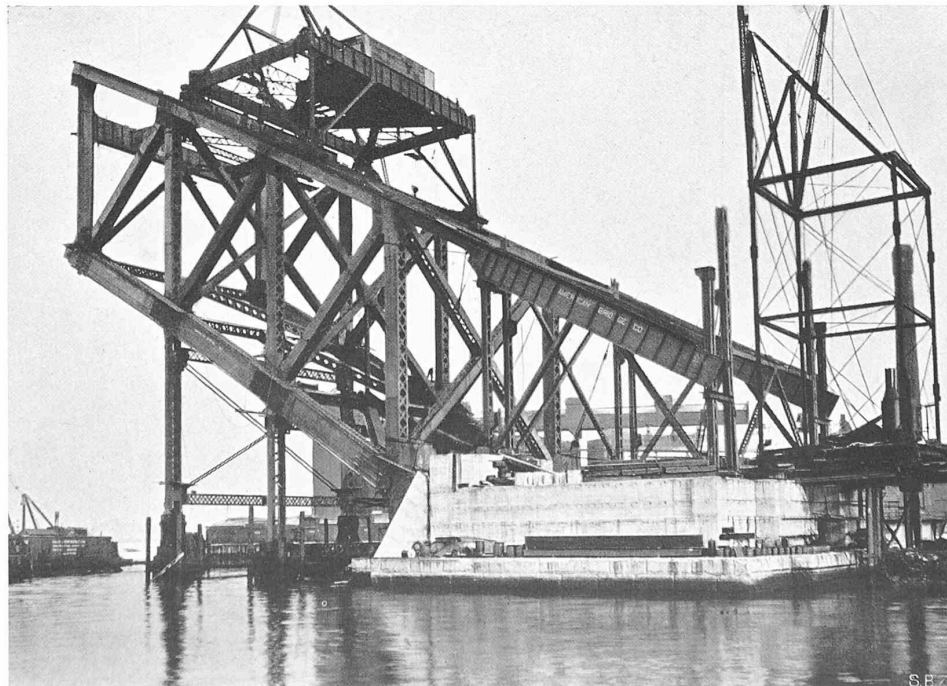
BRÜCKE ÜBER DEN KILL VAN KULL — MONTAGE DES HAUPTBOGENS
