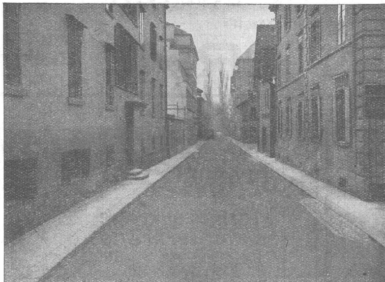
GLARNISCHSTRASSE ZÜRICH Walz-Asphalt: Topeka, 6 cm stark
