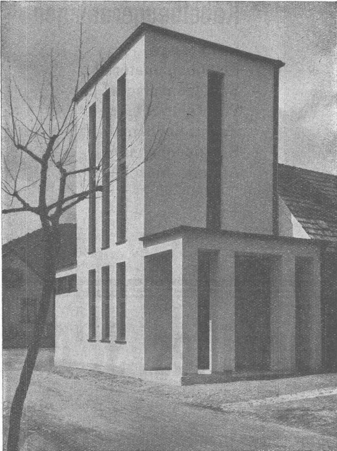
Neubau Brunnenhaus Maxquelle, Bad Dürkheim Holzfachwerk mit Heraklithverschalung
