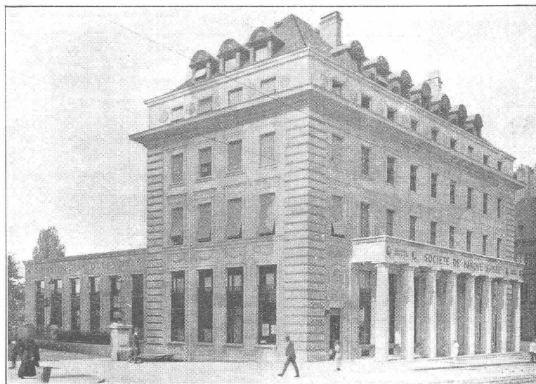
Nouvel Hôtel de la Société de Banque Suisse, Lausanne. Architectes: Schnell, Tnévenaz & Bonnard, Lausanne. Isolation en Mammouth des terrasses et des corniches, 1400 m 2 , exécuté par la
