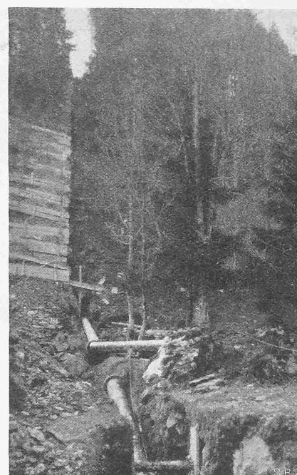
Abb. 16. Rohrgraben auf der Steilstrecke, links provisorische Aushubdeponie.
