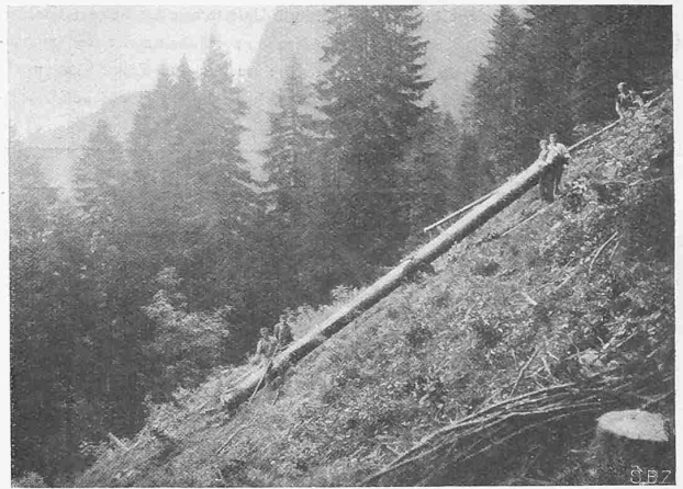
Abb. 11. Hinablassen der 12 m langen Stahlrohre über den Steilhang.
