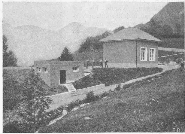
Abb. 19. Der „Messkeller“ unterhalb des Maschinenhauses.
