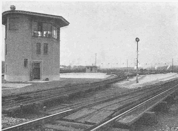
Abb. 21. Geleisebremsen I und II beim Stellwerk IV.
