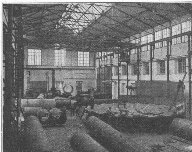
Unsere Kesselschmiede-Werkstatt. Eiserne Baukonstruktion und Kranträger, erstellt 1923.
