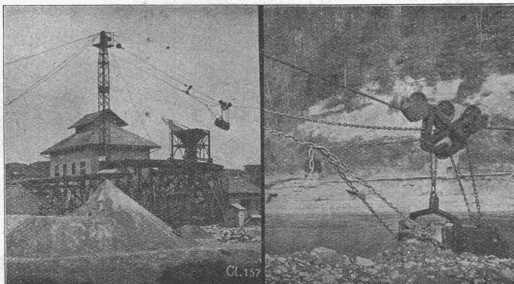
Kabelbaggeranlage in der Sense bei Laupen.
