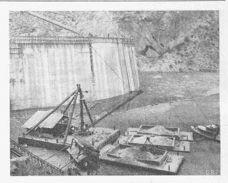
Abb. 6 und 7. Materialtransport zur Betonieranlage am linken Felshang beim Bau der Horse Mesa Staumauer am Salt River.
