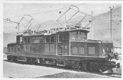
Abb. 3. Einphasen-Wechselstrom-Zahnradlokomotive der Bahn Visp-Zermatt.
