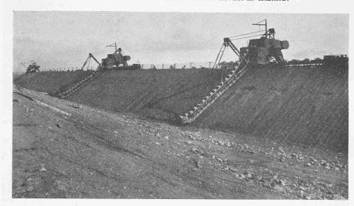
Abb. 3. Kanal-Aushub mittels Baggern von je 375 m<sup>3</sup> Stundenleistung.
