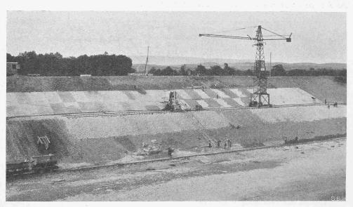
Abb. 4. Verkleidung der Kanalböschungen: Steinschlag, von 1 m über H.-W. bis 1 m unter N.-W. mit Beton abgedeckt,
