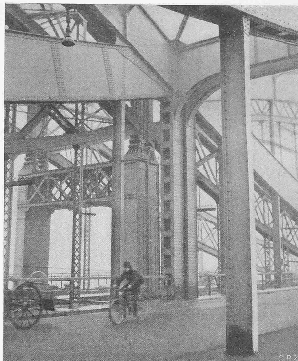
Abb. 2. Alte und neue Brücke: Einzelheiten beim Auflager.
