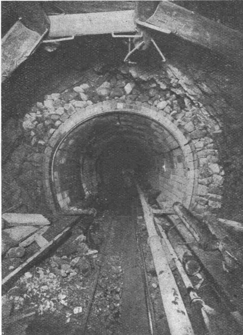
Stollenbau System „Bauschäfer“ der Zementwerke A. G. Hausen bei Brugg
