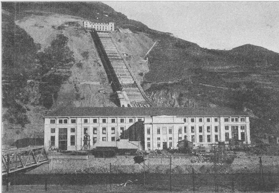
Abb. 8. Wasserschloss, Druckleitung und Zentrale in Kardaun.
