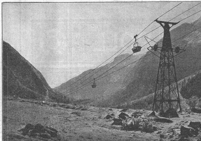
Drahtseilbahn für die Zuführung von Bau-material zum Bau der Grimselstalsperre.
