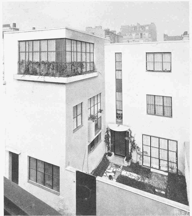
Abb. 10. Ansicht des Hauses J. Lurçat von der Strassen-(Garten-)Seite.
