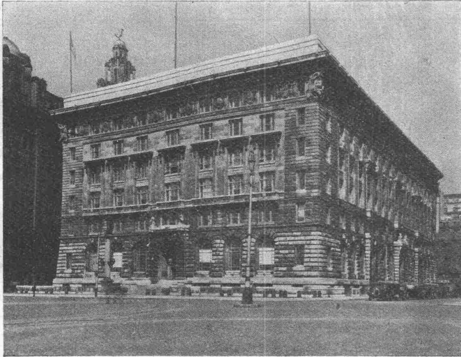
Hauptverwaltungsgebäude der Cunard-Schiffahrtslinie, London (Fundamentabdichtung)
