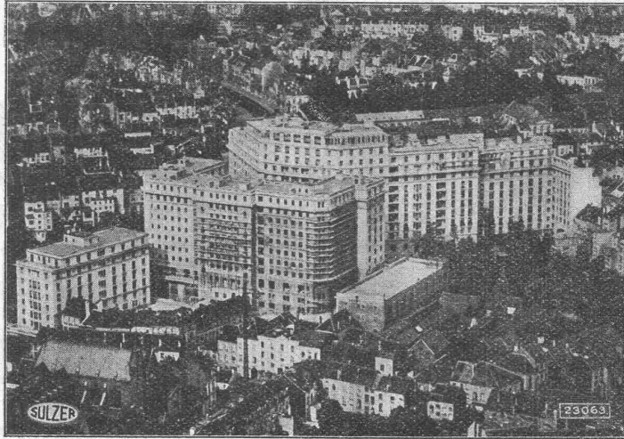
„Résidence Palace“ Brüssel ausgerüstet mit Sulzer-Fern-Warm-
