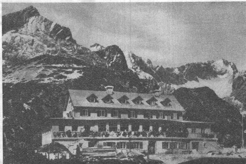
Zöpplitzhaus am Kreuzegg (1652 m). Aussen- und Zwischenwände im ersten Stock und Dachstock in Heraklith-Bauweise ausgeführt.
