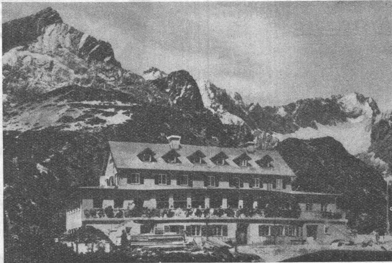
Zöppritzhaus am Kreuzegg (1652 m). Aussen- und Zwischenwände im ersten Stock und Dachstock in Heraklith-Bauweise ausgeführt.
