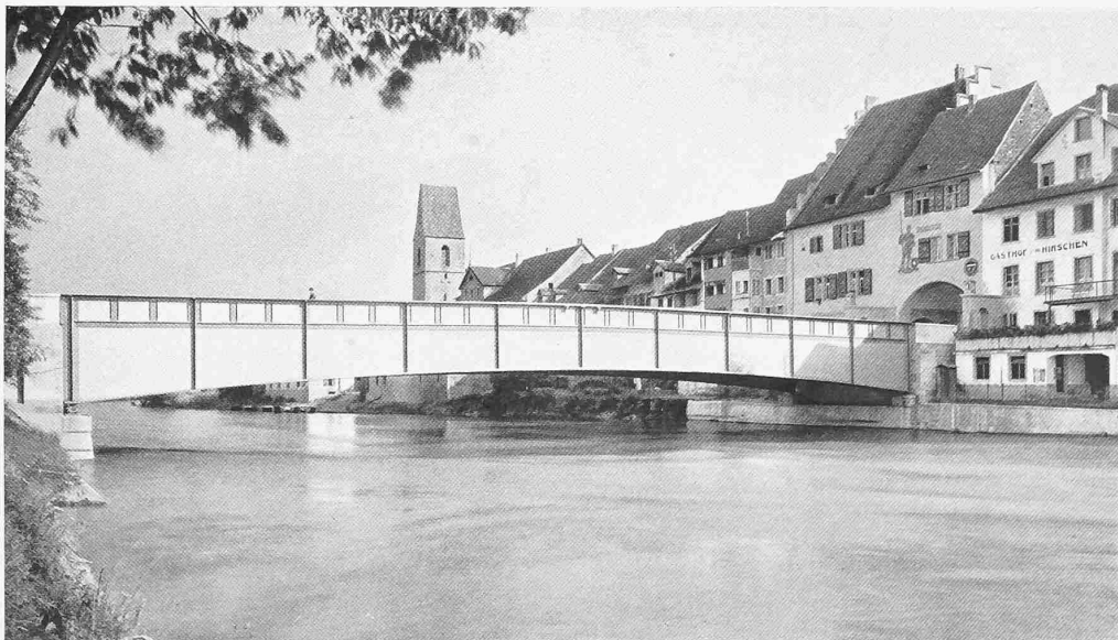
ANSICHT AUS NORDWEST, FLUSSAUFWÄRTS
