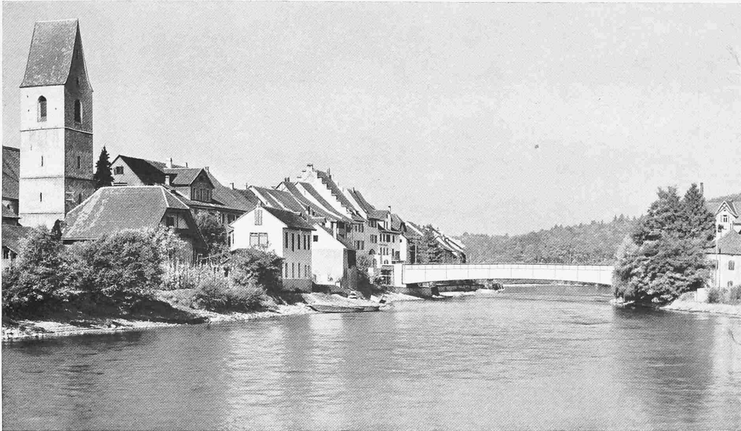
DIE NEUE EISERNE REUSSBRÜCKE IN MELLINGEN ANSICHT AUS OSTEN, FLUSSABWÄRTS
