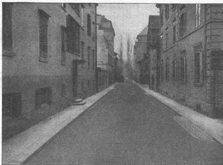
GLARNISCHSTRASSE ZÜRICH Walz-Asphalt: Topeka, 6 cm stark
