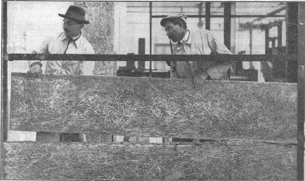
**Über 36 000 qm Heraklithwände im Neubau einer Automobilfabrik**
